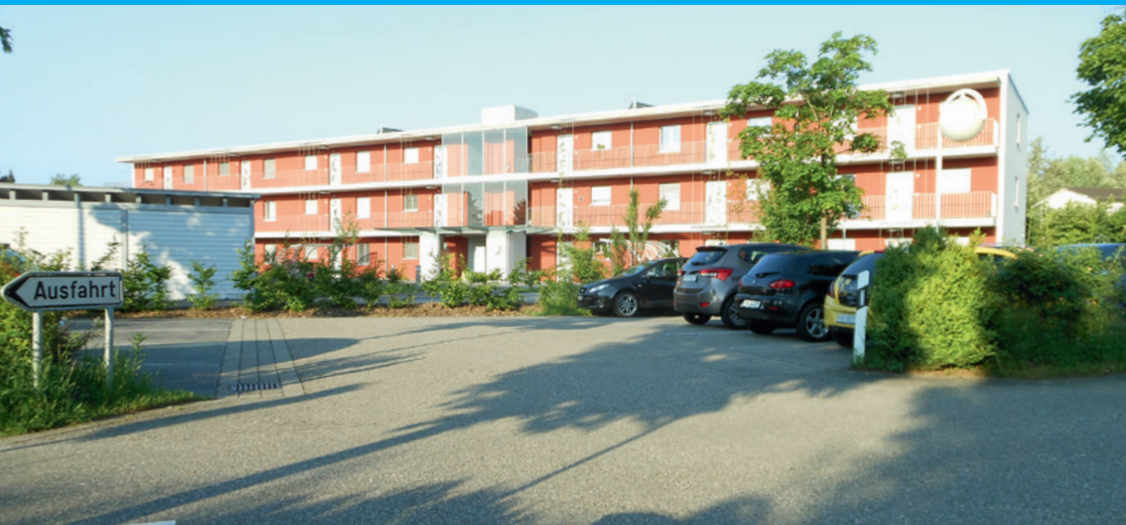
In den letzten zehn Jahren ist Subingen überdurchschnittlich gewachsen. Dabei entstanden ganze neue Wohnquartiere, im Bild der Birkenweg.
