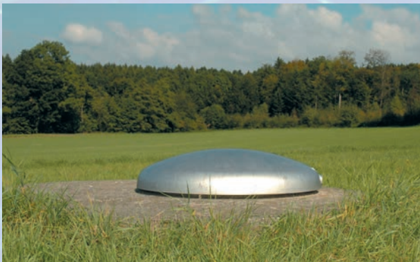
Quellfassungen Hirserenbrunnen und Widlibrunnen
