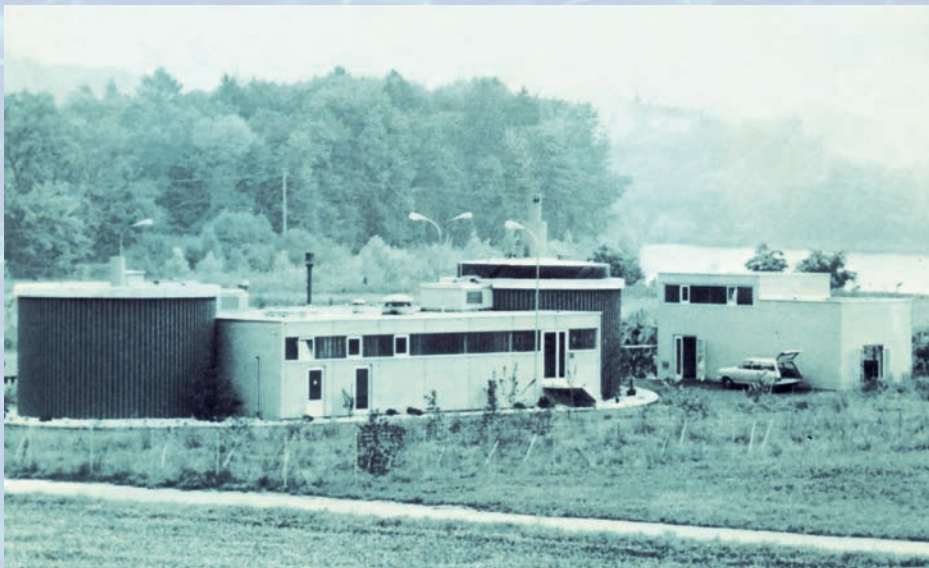
Alte Abwassersanierungsanlage „Schachen“ in Deitingen
